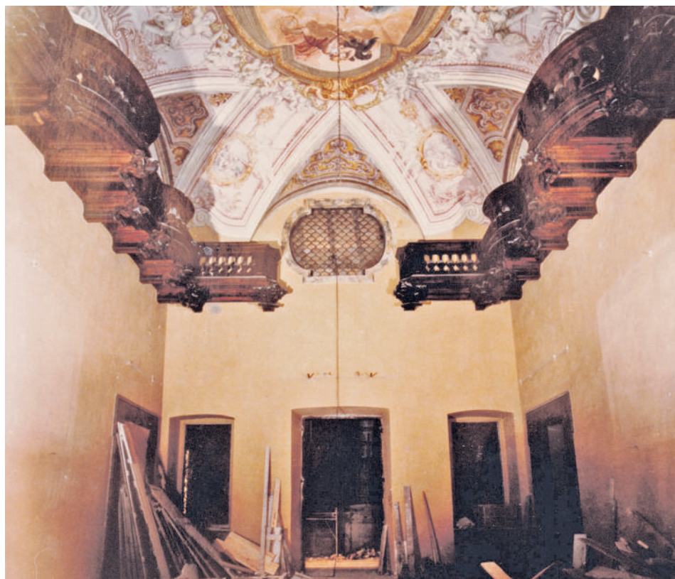
Palazzo Donini. Il Salone d'Onore prima dei lavori di ristrutturazione. (Archivio Salvatici-Ripa di Meana).
